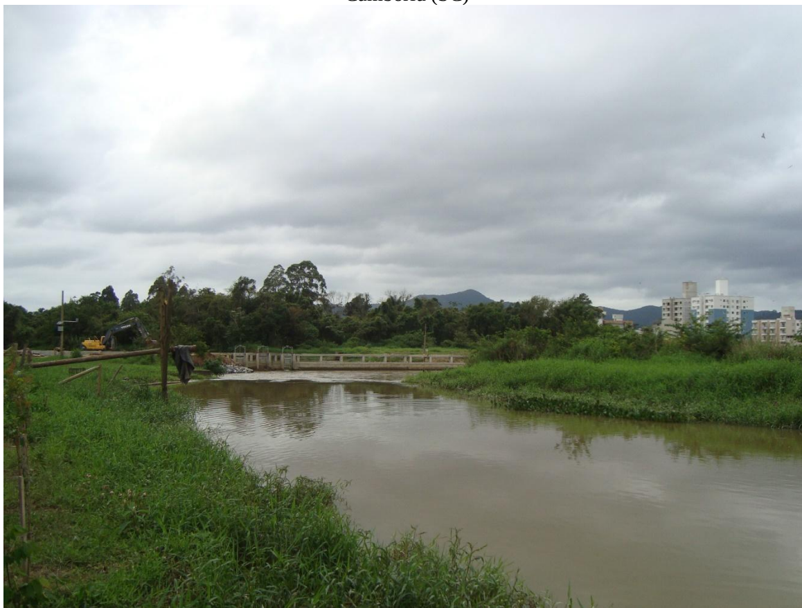
Figura 37 - Barragem da EMASA no Rio Camboriú para barrar a intrusão salina, Balneário Camboriú (SC)
